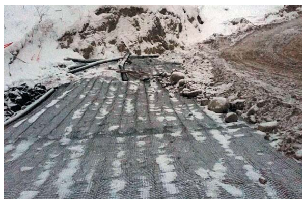
Рис. 9. Армогрунтовая (из полуобойм из базальтволоконной георешетки) насыпь с крутизной откоса 1:1 (Мурманск)
