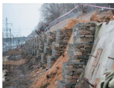
Рис. 4. Различные типы современных конструкций армогрунтовых стен
