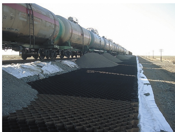
Рис. 4. Геоячейки «ПРУДОН-494» в конструкции основания железнодорожных путей
