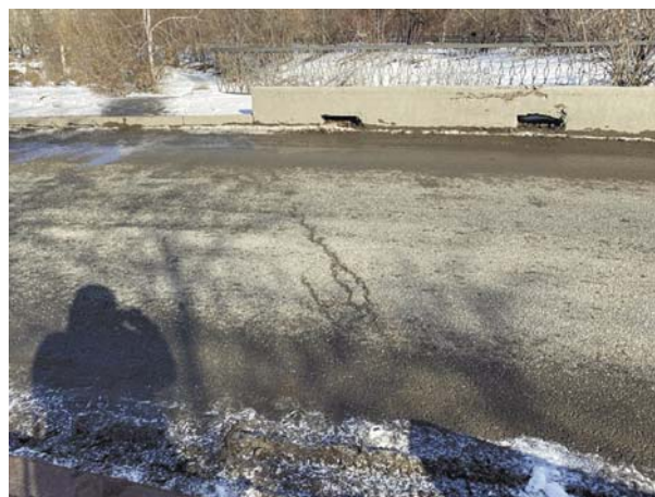
Рис. 4. Разная степень деформирования покрытия над перекрытыми деформационными швами
