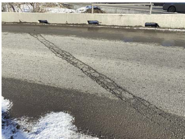
Рис. 4. Разная степень деформирования покрытия над перекрытыми деформационными швами
