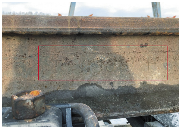
Рис. 1. Изношенная выпуклая маркировка на инвентарном рельсе
