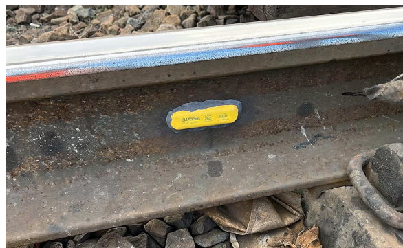
Рис. 5. Испытание клеевого соединения в пути
