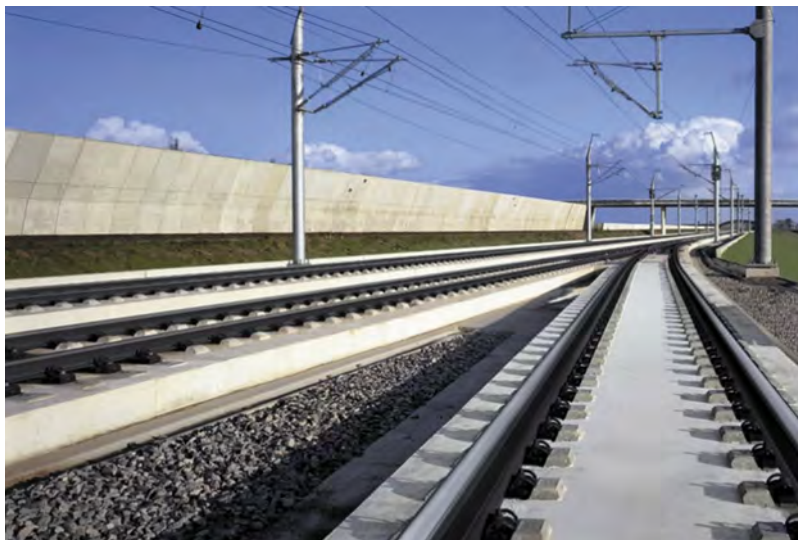
Рис. 3. Безбалластный путь для высокоскоростного транспорта
