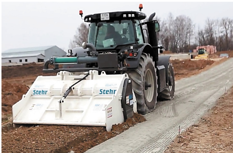
Рис. 2. Этап перемешивания грунта и слоя вяжущего
