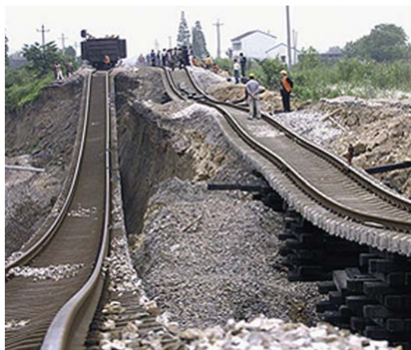
Рис. 1. Провал карстовой воронки на участке 1516-й километр Свердловской железной дороги. Перегон Ергач — Иренский, 1993 г.
