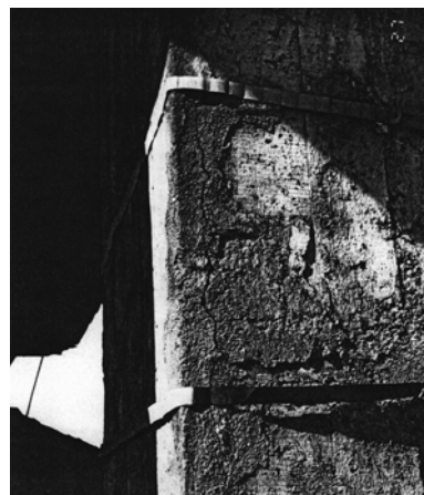
Рис. 2. Скалывание углов стоек рамы
