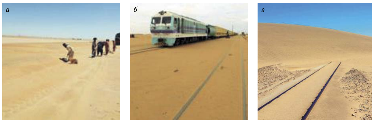
Рис. 1. Занос железнодорожного пути: а, б — засыпание песком; в — наползание бархана
