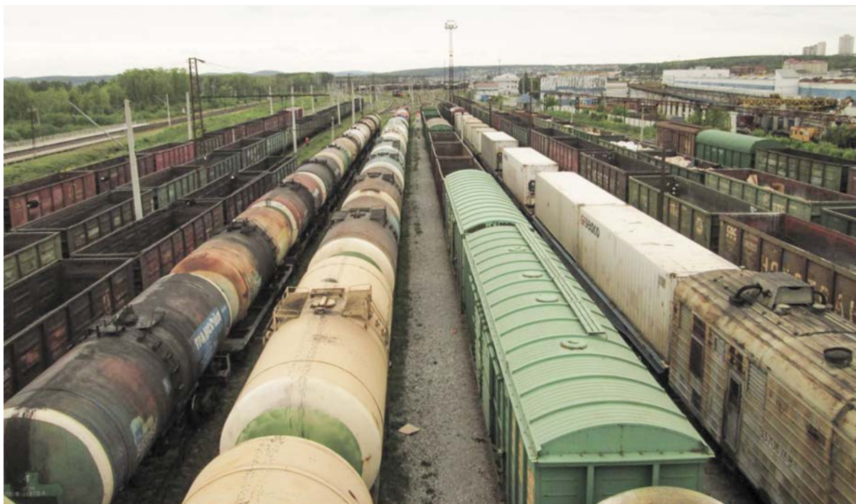
Рис. 3. Четный парк отправления станции Екатеринбург-Сортировочный (4 крайних пути слева — электрифицированные, для приема транзитных поездов)
