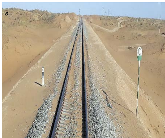
Рис. 2. Категории (степени) заносов песком: а — I категория: занос по головку рельсов; б — II категория: подошвы рельсов засыпаны до головки рельсов, балласт и шпалы частично засыпаны песком; в — III категория: рельсы, балласт и шпалы местами присыпаны
