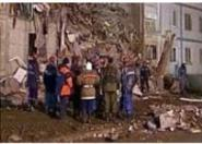
30 января 2011 года произошло обрушение жилого дома на проспекте Ленина в центре города Ярославля. В вечернее время во время ремонта в одной из квартир на первом этаже была снесена несущая стена, что вызвало обрушение пролетных строений в подезде. В результате чрезвычайного происшествия пострадали 18 квартир второго подезда, в которых проживал 31 человек. Под завалами погибла женщина.
