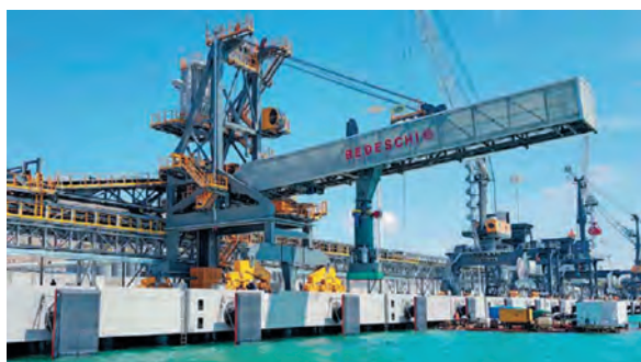
Рис. 4. Балкерный терминал: годовая мощность 3 млн т, причальная стенка длиной 440 м для одновременной погрузки 3 судов дедвейтом 5000 т, 14 зерновых силосов объемом 35000 куб. м, 8 цементных силосов объемом 6000 куб. м [3]
