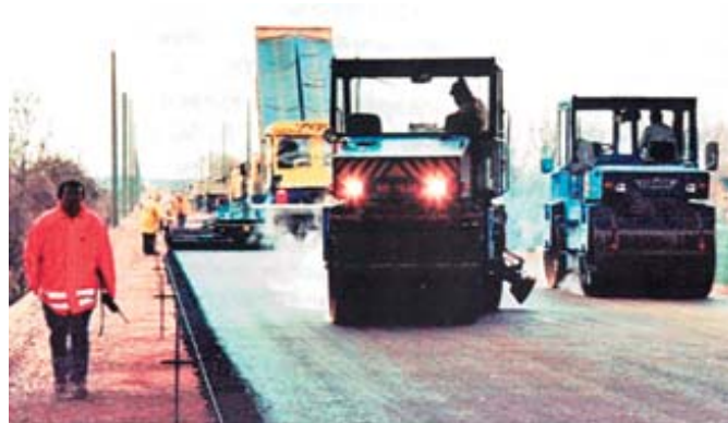
Рис. 12. Производство работ по устройству верхнего строения монолитного асфальтового пути
