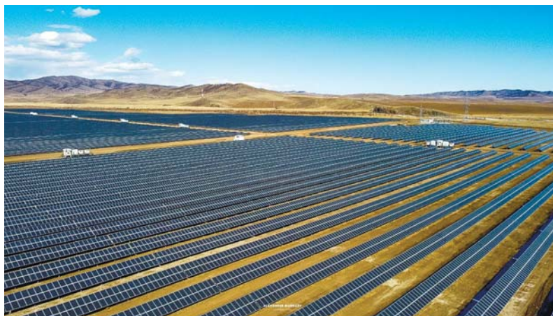
Рис. 4. Торейская солнечная электростанция
