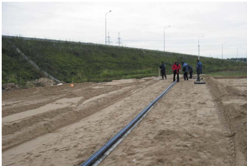
Рис. 3. Устройство инклинометрического измерительного канала на КАД Санкт-Петербурга в 2008 г.
