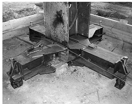
Рис. 8. Конструкция усиления фундамента
