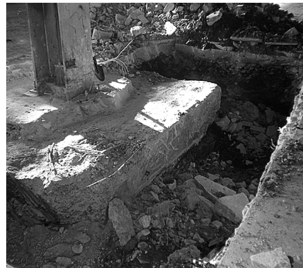
Рис. 2. Общий вид фундамента после вскрытия. В верхней зоне видны арматурные стержни
