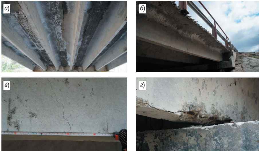
Рис. 2. Дефекты и повреждения железобетонных пролетных строений мостов а — выщелачивание цементного камня; б — морозное разрушение бетона; в — нормальные и наклонные трещины в растянутой зоне главных балок; г — разрушение защитного слоя бетона от продуктов коррозии рабочей арматуры
