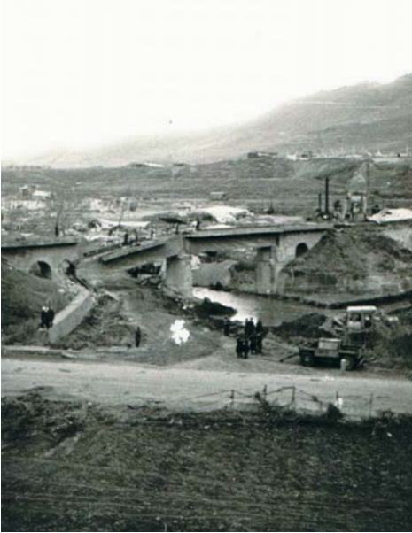
Рис. 4. Повреждение опоры моста подъездного пути к сахарному заводу в Спитаке [15]
