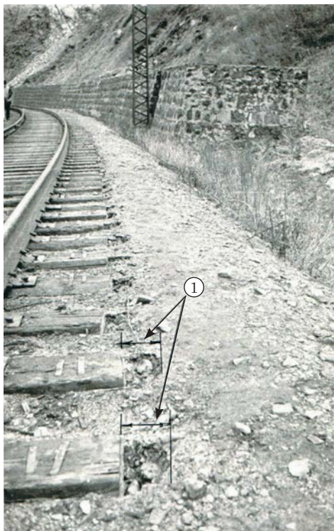
Рис. 2. Смещение рельсошпальной решётки 1 в сторону откоса полунасыпи [15]
