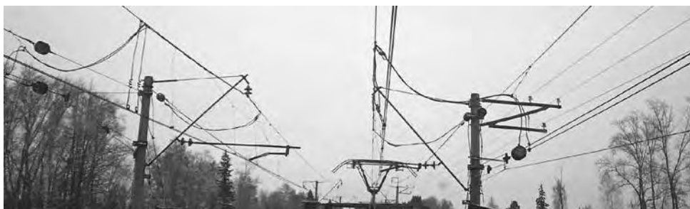
Рис. 5. Обвод усиливающих проводов на сопряжении АУ
