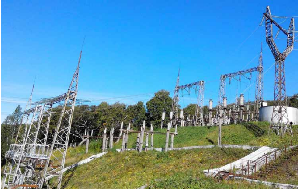
Рис. 2. Пример расположения молниеотводов и защищаемых объектов (ошиновки, разъединителей и шинных опор подстанции) на склоне
