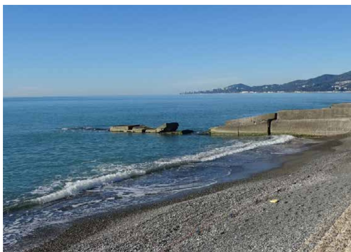
Рис. 3. Разрушенная бетонная бунa напротив железнодорожной станции Адлер
