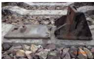
Рис. 2. Характерный вид разрушения подкладок контррельса
