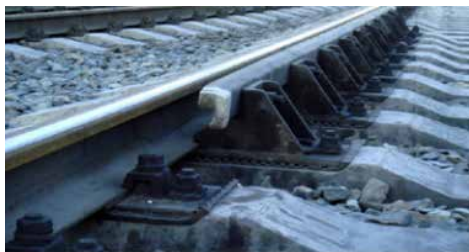
Рис. 1. Подкладка контррельса ПКЖДЛ 65-4
